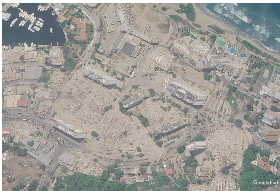
Vista aérea, edificios de la OP PP 26, OP PP 27, y Residencias Caribe, tras el doblete sísmico. Zona cero. Urbanización Caribe, Caraballeda – La Guaira. Fuente: Google Earth (2026)
